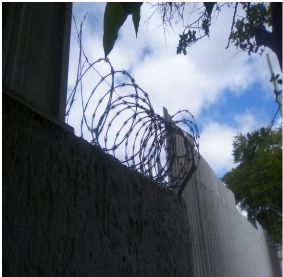
Se realizó instalación de concertina (alambrado).
