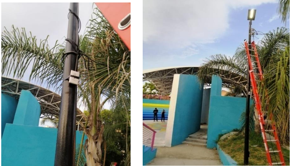
Instalación de toma de contacto y luminarias.
