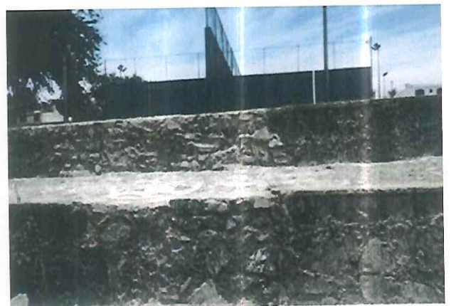
Reparación socavón, muro contención en la Unidad Deportiva “Unidad habitacional UAG”
