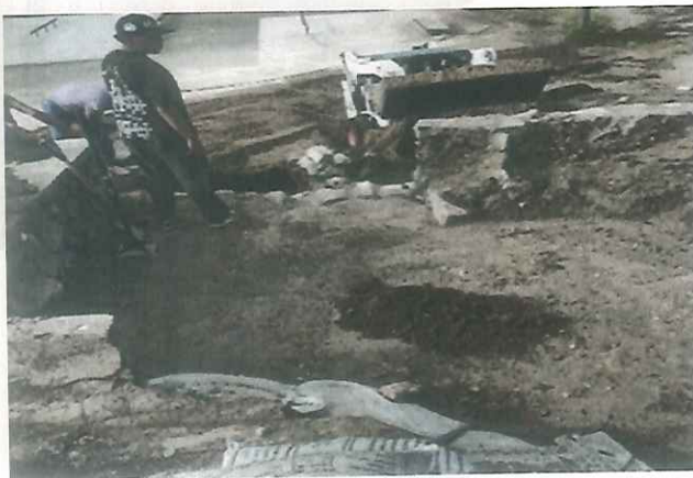
Reparación socavón, muro contención en la Unidad Deportiva “Unidad habitacional UAG”
